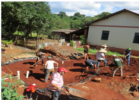
Figura 1. Construção de Bacia de Evapotranspiração. Piracicaba-SP
