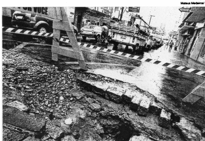
DANOS Buraco no cruzamento das ruas XV de Novembro com José Pinto de Almeida: rede de esgoto entupida
