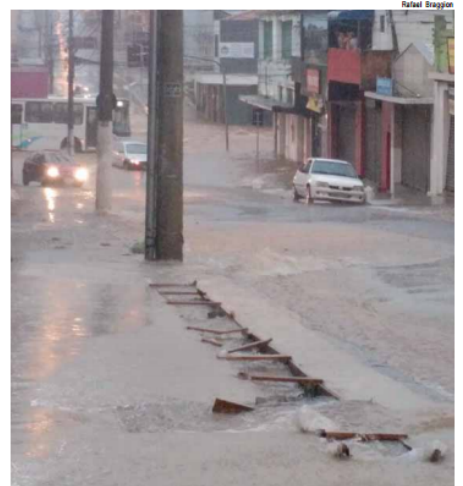
Avenida Armando Salles ficou alagada devido à forte tempestade
