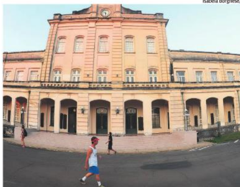
Fachada do prédio central será restaurada com quase R$ 1 mi
