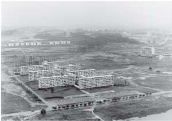
Construção do Crusp, na Cidade Universitária, na década de 1960
