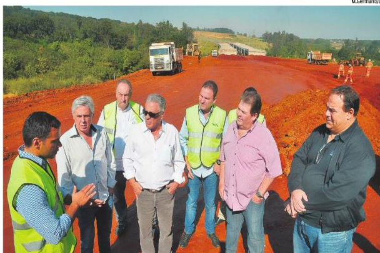
Gerente de engenharia disse que restam 300 metros de obras para conclusão dos serviços
