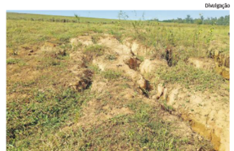
Erosão impede o crescimento da vegetação
