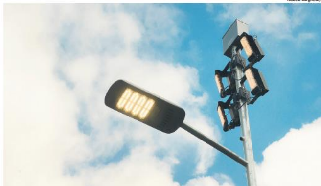
Novas lâmpadas de LED vão substituir lâmpadas antigas a vapor, de 250 a 400 watts
