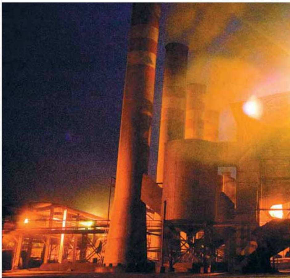
Caldeiras da Usina Santa Elisa, em Sertãozinho (SP): produção de energia elétrica com bagaço de cana
