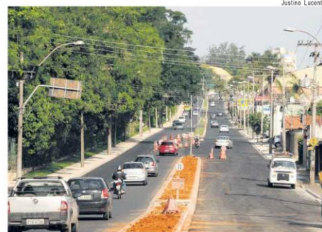
Obras acontecem na última quadra da avenida
