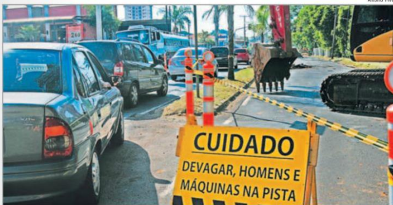
A recuperação da Centenário compreende diversos serviços, como drenagem de águas pluviais e novo asfalto
