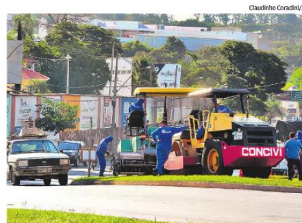
Obras na Centenário avançam e parte de trecho será liberado
