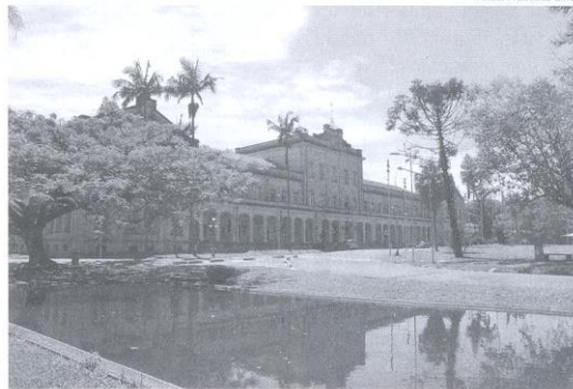
O centenário edifício principal da Esalq: tradição misturada com inovação
