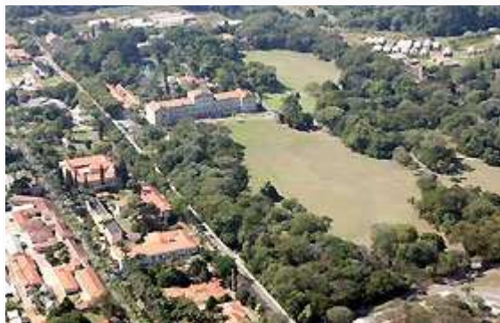
Vista aérea da área da Esalq.
