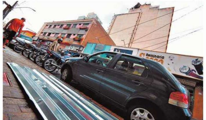
Telha que caiu do alto de um prédio na rua XV de Novembro ontem à tarde: susto e prejuízo
