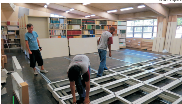
Funcionários durante a montagem dos trilhos das estantes deslizantes.
