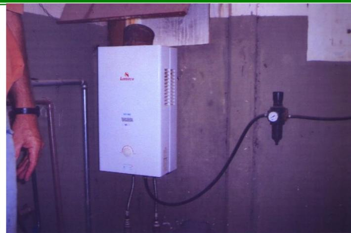
AQUECEDOR DE AGUA, USANDO BIOGÁS
