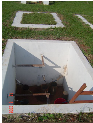
FIGURA 7– Poço de coleta de drenagem dos lisímetros.
