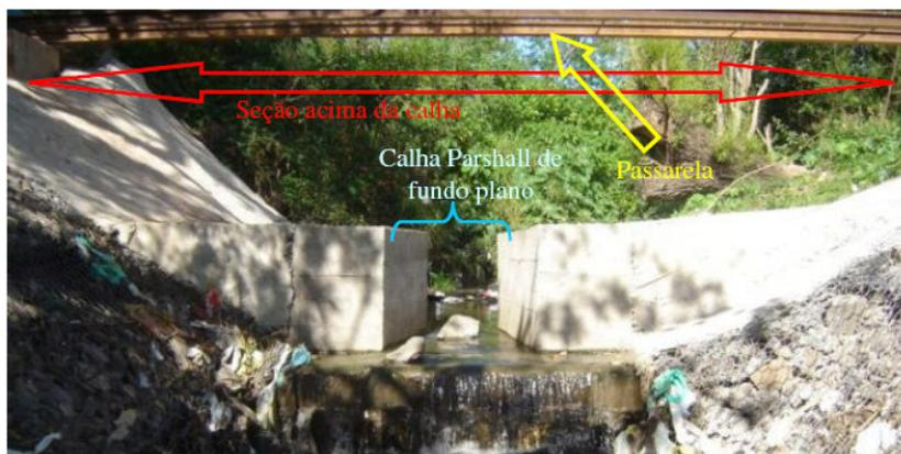
Figura 5: Perfil da estação fluviométrica.
