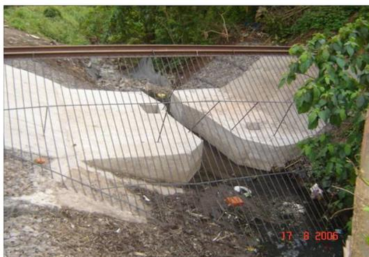
Figura 4: Estação de monitoramento fluviométrico.
