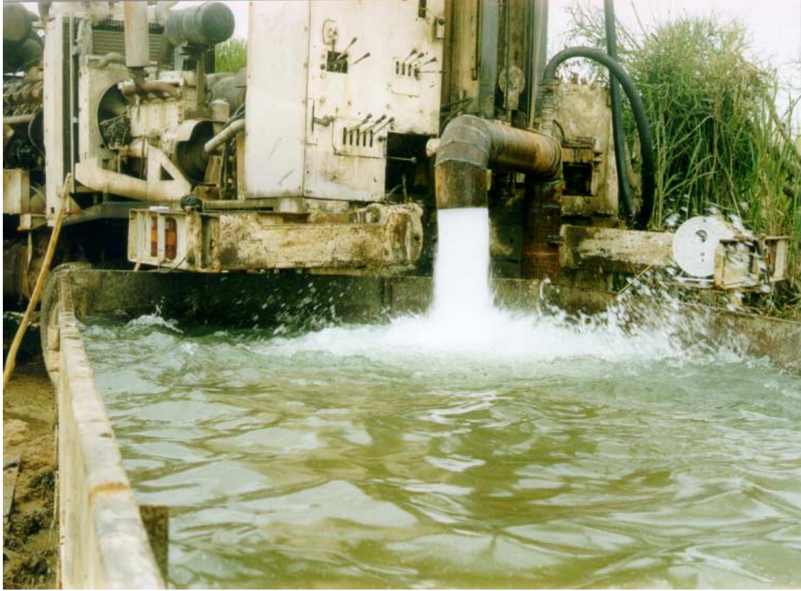
Foto da Capa: Teste de bombeamento em poço tubular construído em terrenos sedimentares no Município de Campos dos Goytacazes (Egmont Capucci)
