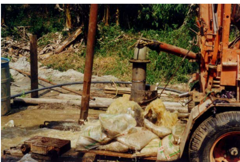
Fotografia 8 - Água com elevada turbidez proveniente da lavagem da seção filtrante do poço.
