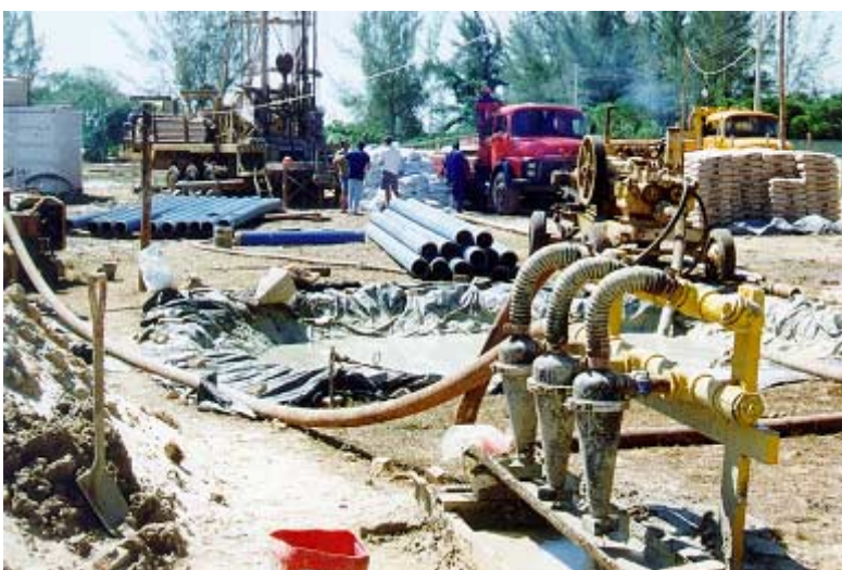
Fotografia 11 - Canteiro de obras utilizando sonda rotativa. Poço GRUSSAI, CEDAE, em S. João da Barra.
