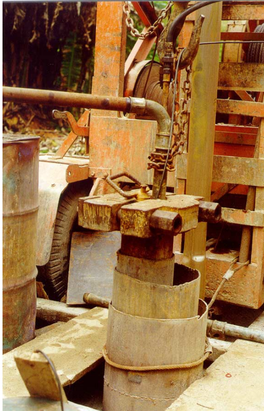
Fotografia 1- Tubos de cravação telescopados a partir de 14 polegadas.
