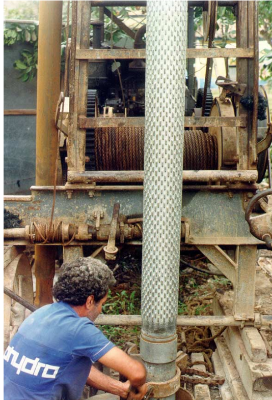
Fotografia16 - Aspecto da instalação de filtros tipo NOLD em poço em cristalino.
