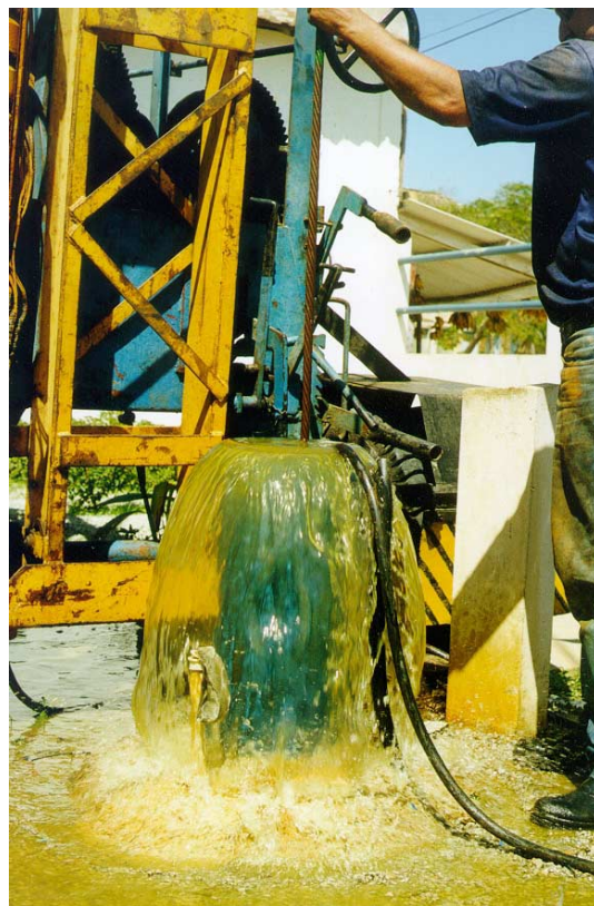
Fotografia17 - Desenvolvimento de poço pelo método de pistoneamento, utilizando-se produtos químicos a base de ácido cítrico.
