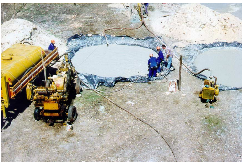
Fotografia 13- Tanques de bomba de lama em obra executada por sonda rotativa em BARRA DO AÇU, S. J. da Barra, CEDAE.
