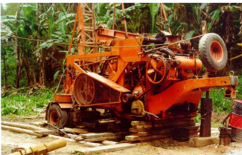
Fotografia 5 - Sonda percussora devidamente equipada.
