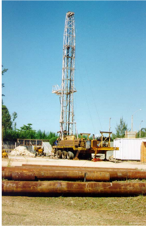
Fotografia 14- Em primeiro plano, tubos de revestimento preliminar em obra de construção de poço em sedimento, utilizando sonda rotativa em ATAFONA, S. J. da Barra, CEDAE.
