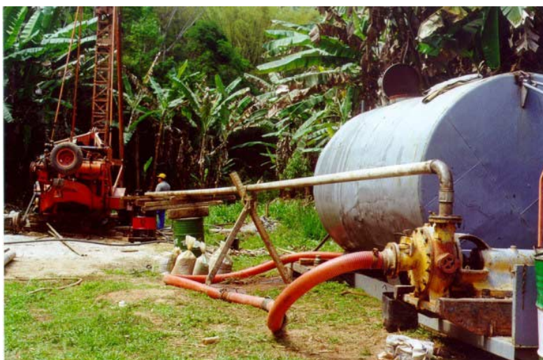
Fotografia 7 – Trabalho de desenvolvimento de poço utilizando-se pipa d’água e bomba de grande capacidade.
