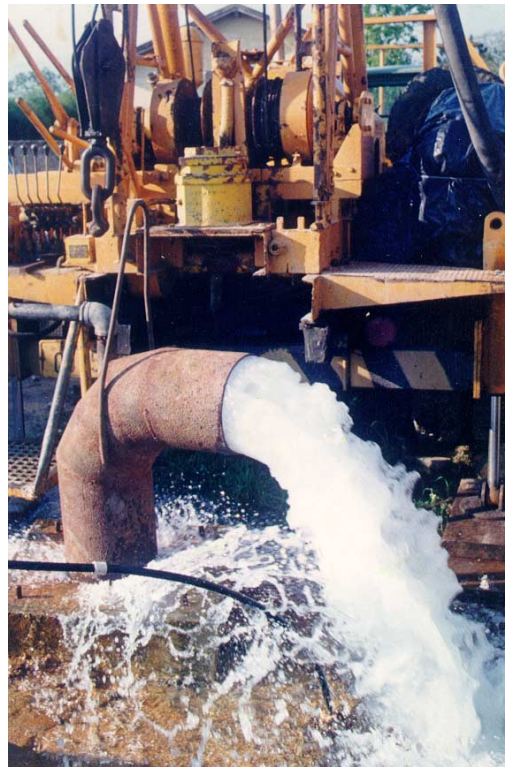
Fotografia 15- Serviços de bombeamento do Poço de DONANA-01 com taxa de bombeamento de 500 metros cúbicos por hora.
