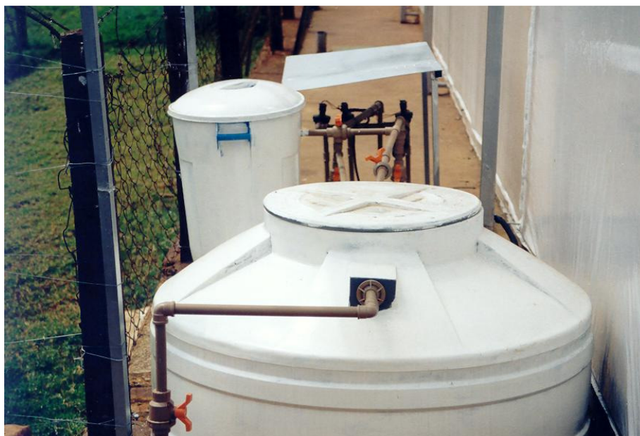
Figura 4. Caixa d'água, tanque de fertirrigação, bomba e válvulas do sistema de irrigação, Projeto e execução: Aquasolo, Piracicaba – SP.
