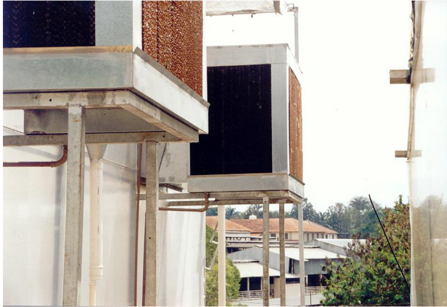
Figura 5. Resfriadores evaporativos da casa-de-vegetação. Vazão de ar: 36.000 m 3 /hora (18.000 m 3 /hora/cada equipamento). Potência instada: (1 ½ cv em cada equipamento). Tensão: 220v trifásico. Consumo máximo estimado de água evaporada: 100-200 litros hora. Dimensões mm. (alt. x larg. x prof.): 1,9 x 1,7 x 1,8 m. Consumo total de energia: 3 KVA. Peso de cada equipamento: 145Kg. Elementos evaporativos: Celulose Celdek-Munters. Dutos de distribuição: tubulões de polietileno alta densidade com diâmetro de 50". Projeto e Execução: Jardim Estufas, Piracicaba – SP.
