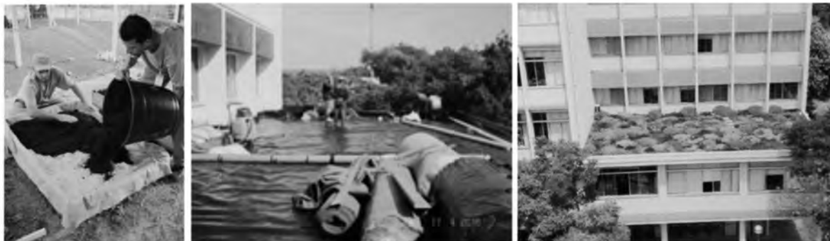
Figuras 2, 3 e 4 – Preparação, execução da impermeabilização e telhado verde (prédio 5) e montagem dos protótipos
