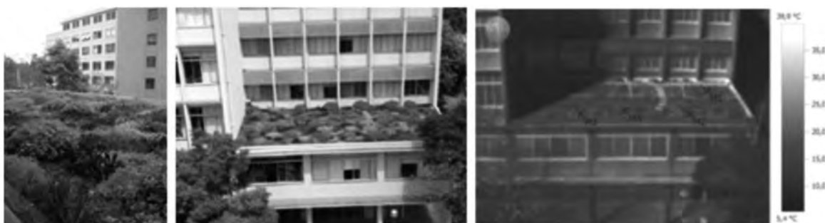
Figuras 5, 6 e 7 – Telhado verde (prédio 5); telhado verde (prédio 5) e foto termográfica (temperatura superficial da laje após intervenção e redução da ilha de calor)
