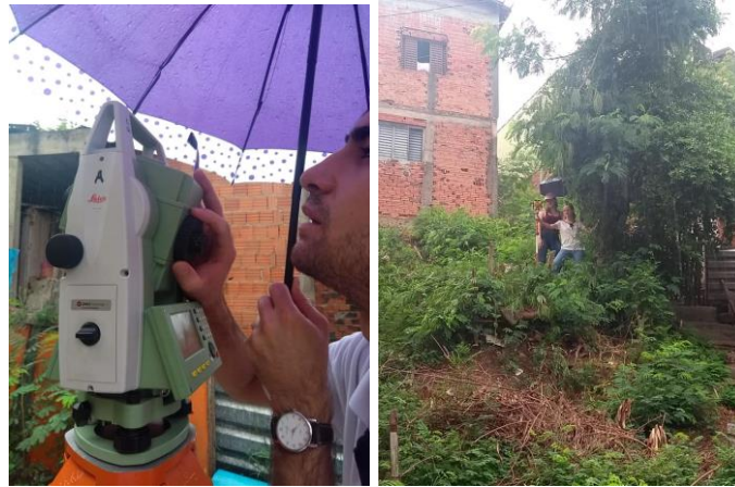
Alunos realizando o levantamento topográfico na primeira área no bairro no Monte Líbano (Artur Diaz, Natália Ré e Larissa Cardoso).
