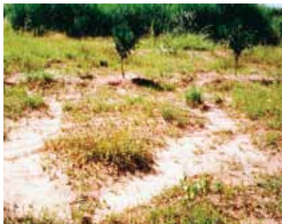
FIGURA 2 | O USO INADEQUADO DA GRADE NO PERÍODO CHUVOSO PODE LEVAR A SÉRIOS PROBLEMAS DE EROSÃO
