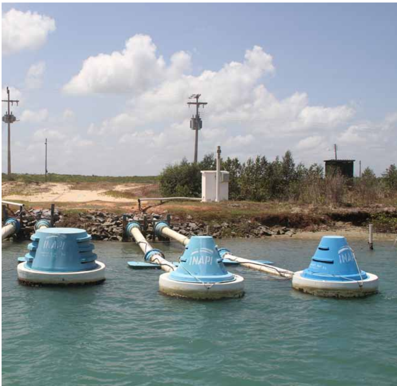
Bombas captam água em manguezal para uma produção de camarão; Fortaleza, CE, 2011
