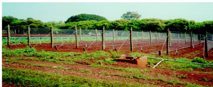
Figura 4 - Detalhe da instalação da rede agrícola.
