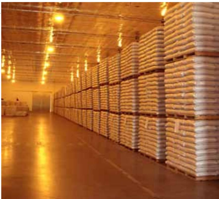
**Figura 23.** Armazém de sementes mostrando detalhes de emblocamento paletizado, isolamento térmico (folha de alumínio) no forro e piso de concreto liso e queimado com vedação de umidade
