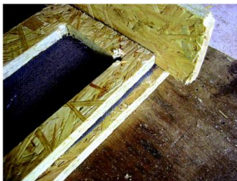
Figura 16 - Checagem das medidas nas laterais com abertura de ventilação
