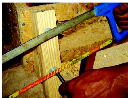
Figura 37 - Cunhas e suportes inferiores parafusados no secador; corte da barra rosqueada
