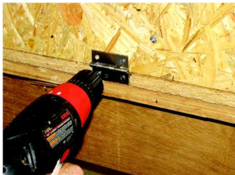
Figura 22 - Fixação das dobradiças na porta
