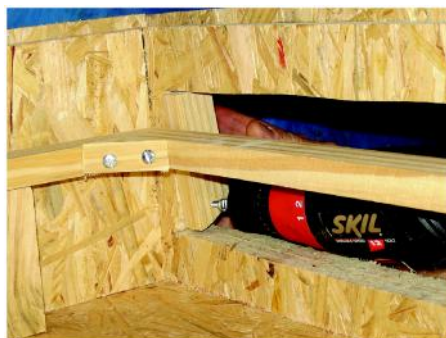
Figura 25 - Local de fixação dos apoios
