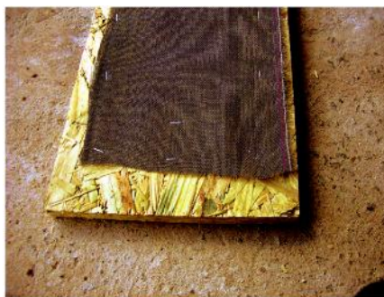
Figura 14 - Tela dupla grampeada na abertura de ventilação
