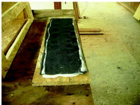
Figura 15 - Cola na peça que será fixada
