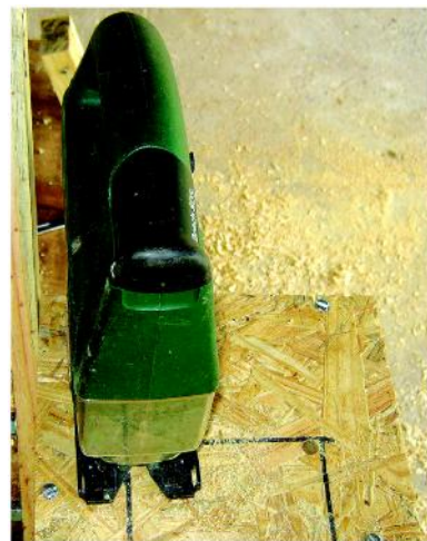
Figura 12 - Corte da abertura com serra tico-tico
