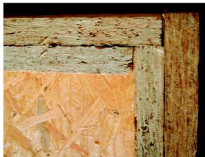
Figura 7 - Encaixe das peças que formam as laterais do secador
