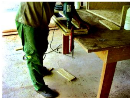
Figura 17 - Parafusando as laterais com abertura de ventilação
