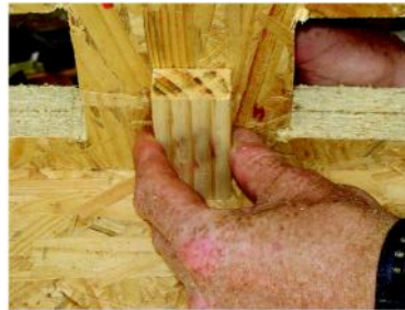
Figura 31 - Marcação do furo na peça interna de 7,5 cm
