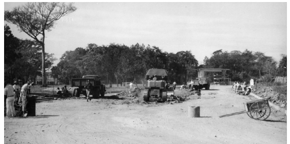
Figura 5. A construção do Portal
