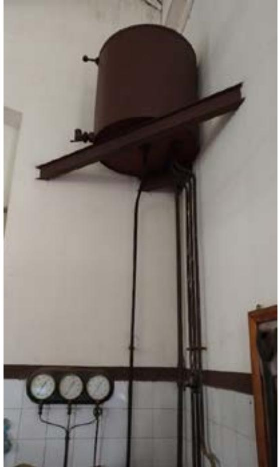
Tanques de água para arrefecer os motores dispostos nas laterais da usina
