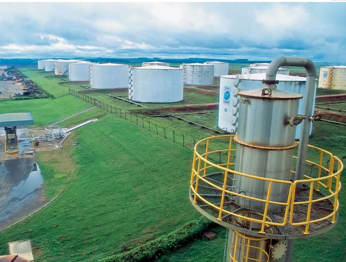
Unidade de armazenamento de etanol
